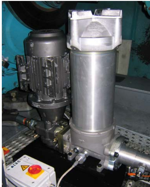
Bild 4.93: Nebenstrom-Filteraggregat
