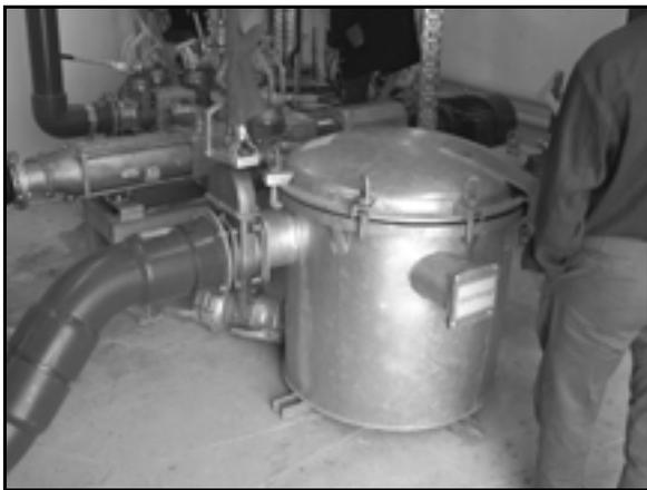
Abb. 3-29: Schwerstoffabscheider in einer Rohrleitung;
