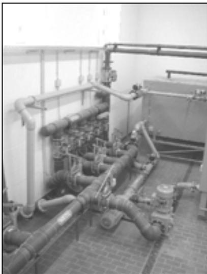
Abb. 3-20: Pumpen in einer Biogasanlage;
