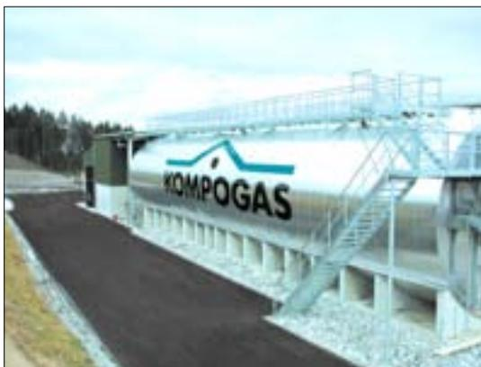
Abb. 3-13: Pfropfenstromfermenter; Foto: Kompogas AG
