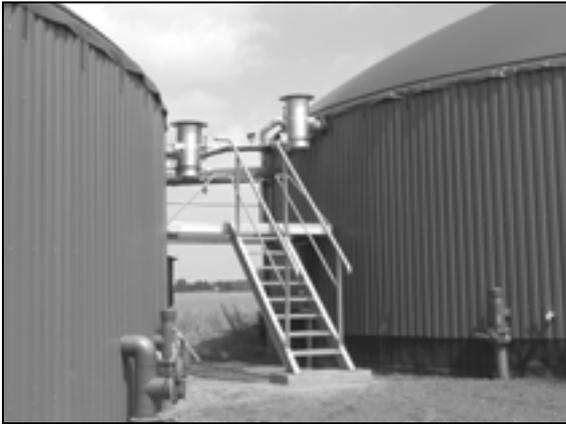
Abb. 3-28: Arbeitsbühne zwischen zwei Behältern mit Rohrleitungen und Drucksicherungen;
