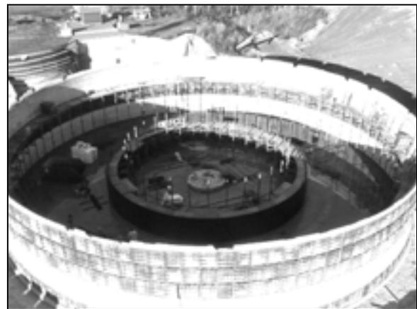
Abb. 3-33: Bau eines Betonfermenters
