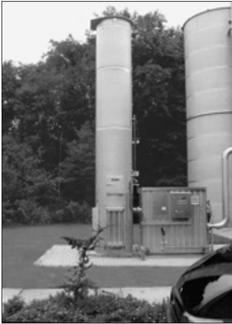
Abb. 3-43: Notfackel einer Biogasanlage;
