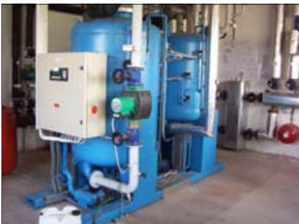
Abb. 5-15: Beispiel einer Absorptionskältemaschine an einer Biogasanlage; Foto: Institut für Energetik und Umwelt gGmbH
