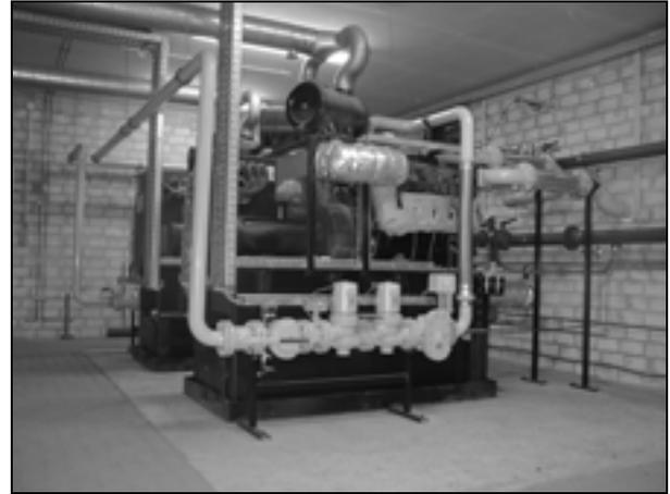
Abb. 5-7: BHKW mit Gasregelstrecke (helle Leitungen);
