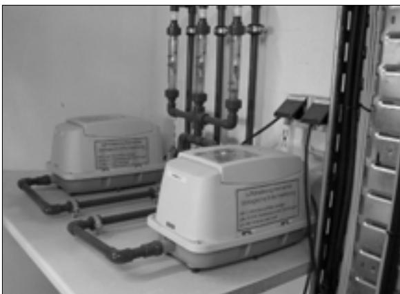
Abb. 5-1: Gasregelung für die Lufteinblasung in den Fermentergasraum; Foto: Institut für Energetik und Umwelt gGmbH
