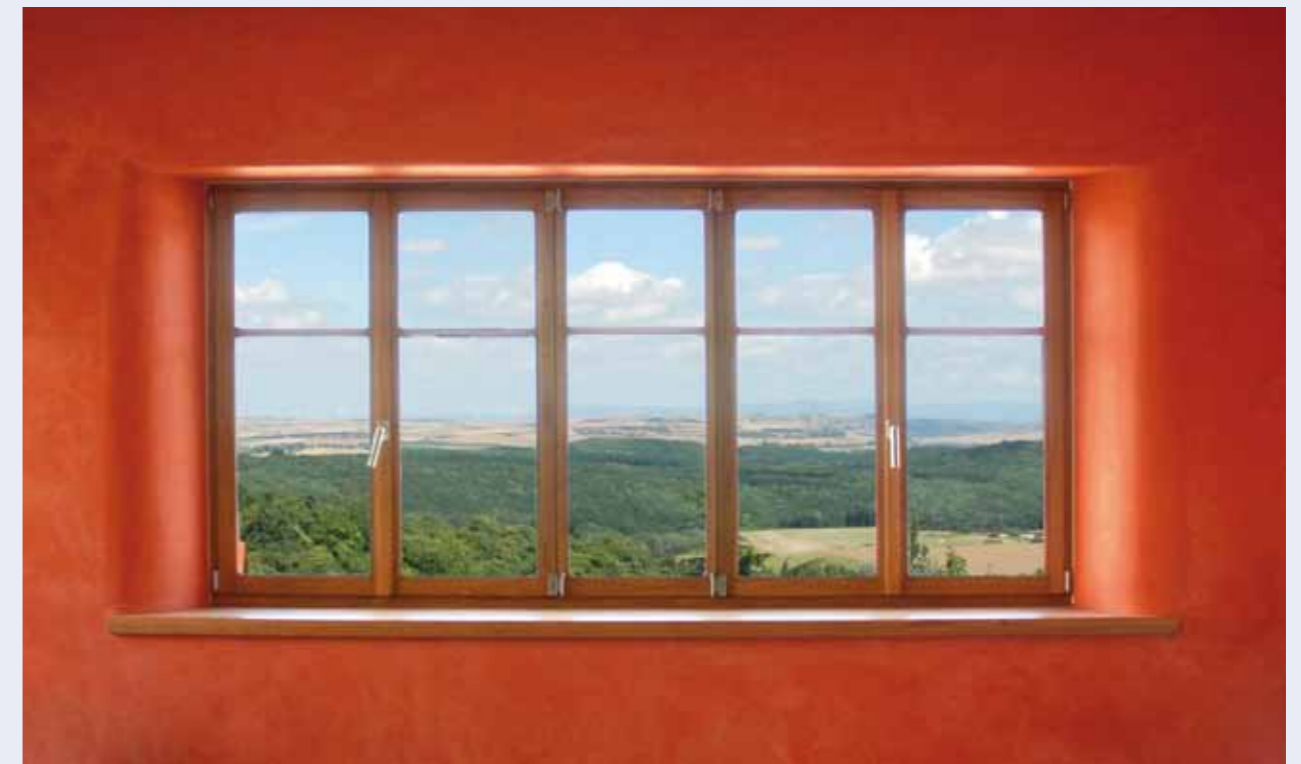
Putz mit Erdpigment eingefärbt
