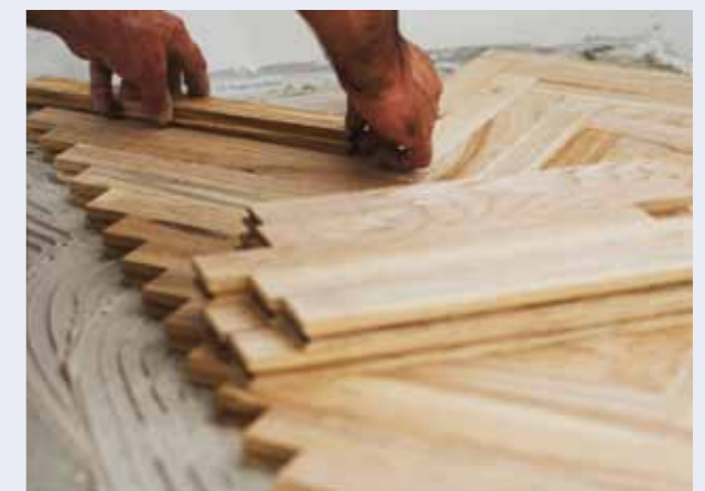
Verlegung von Stabparkett
