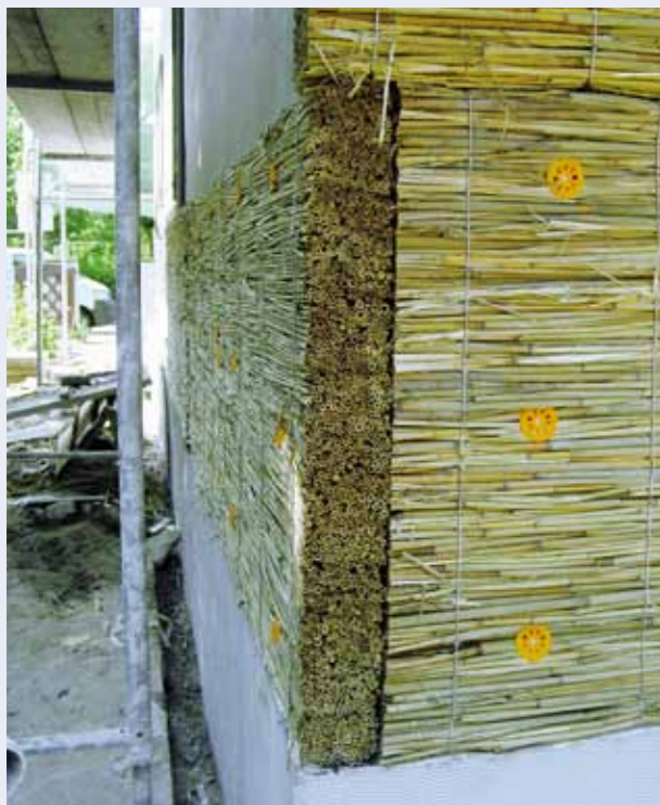
Mit Schilfplatten gedämmte Hausecke
