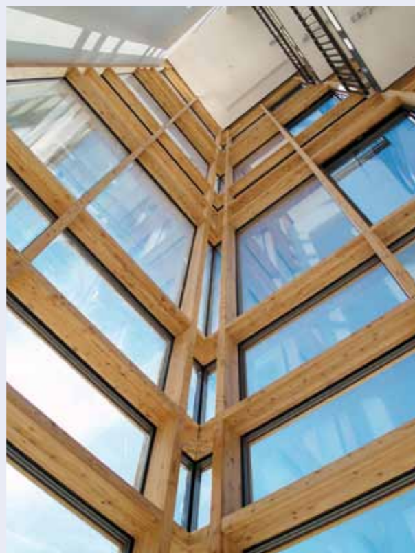
Holz-Glas Fassade Fachgymnasium Preetz
