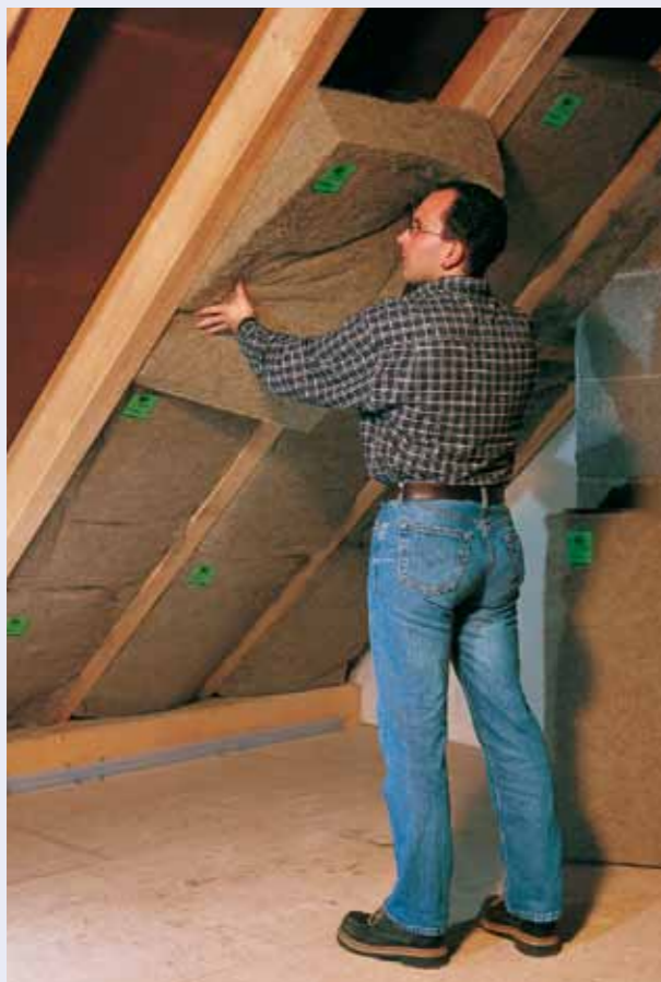
Einbau einer flexiblen Hanfdämmplatte
