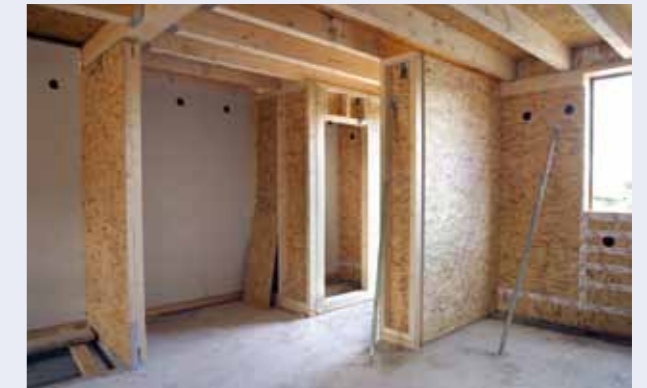
Holzrahmenbau im Neubau
