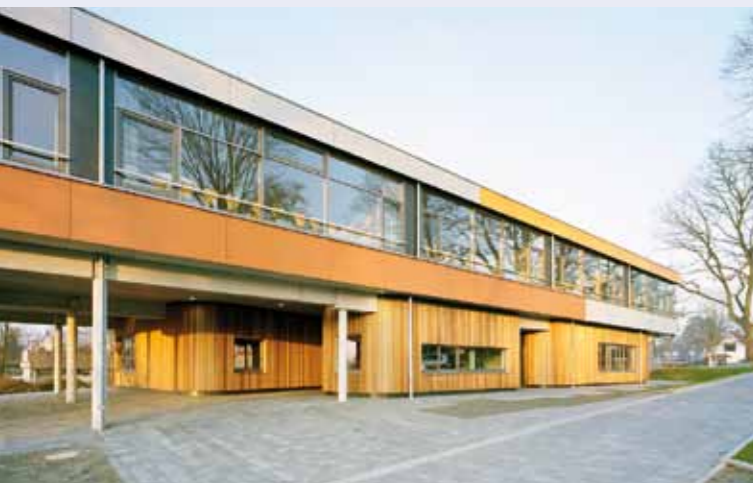
Holz-Glas Fassade Fachgymnasium Preetz
