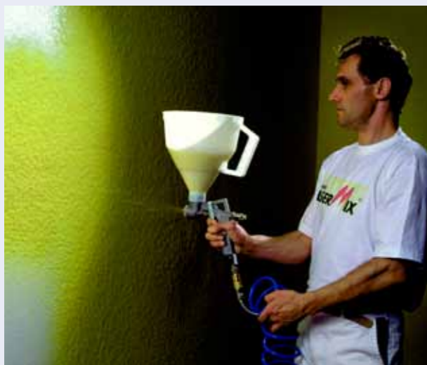
Aufbringen von Zellulose- und Textilfaserputz im Spritzverfahren
