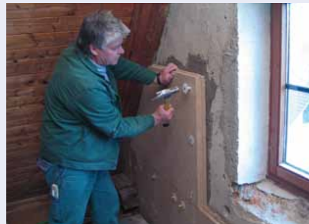
Montage eines Innendämmsystems
