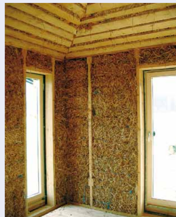
Außenwanddämmung mit Stroh
