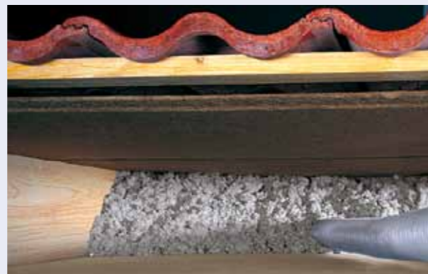
Verarbeitung von Zellulosedämmstoff
