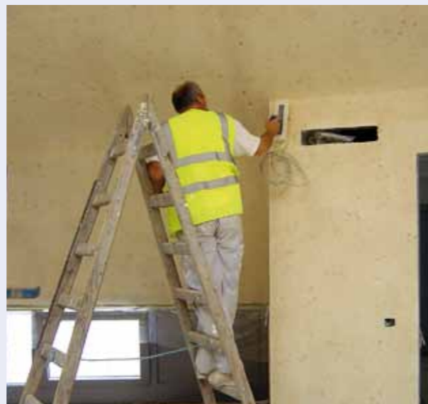
Aufbringen von Zellulose- und Textil-Faserputz
