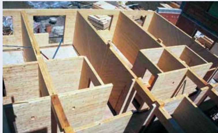
Holzmassivbauweise – Bau mit vollmassiven Naturholzelementen
