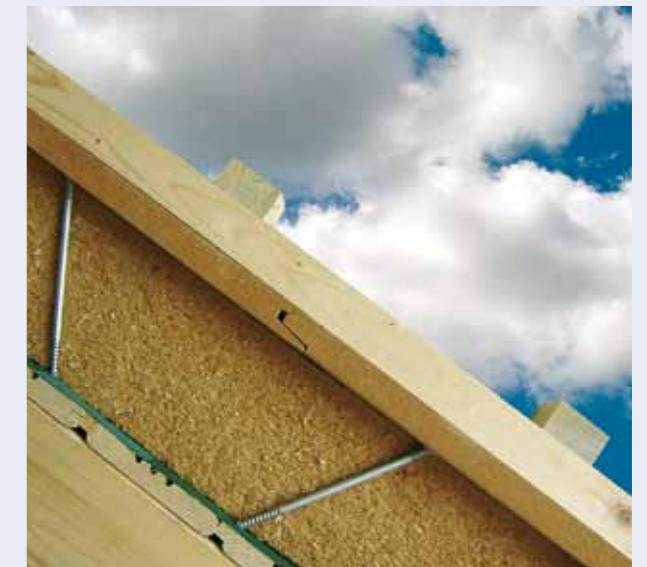
Außendämmung bewohnter Dachräume
