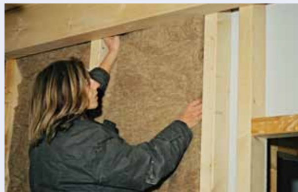
Flachs als Innenwanddämmung
