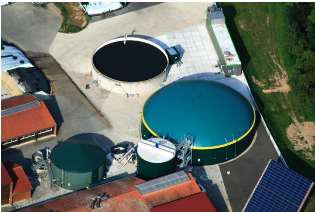
Abbildung 2: Luftbild Biogasanlage am Hessischen Biogasforschungszentrum
