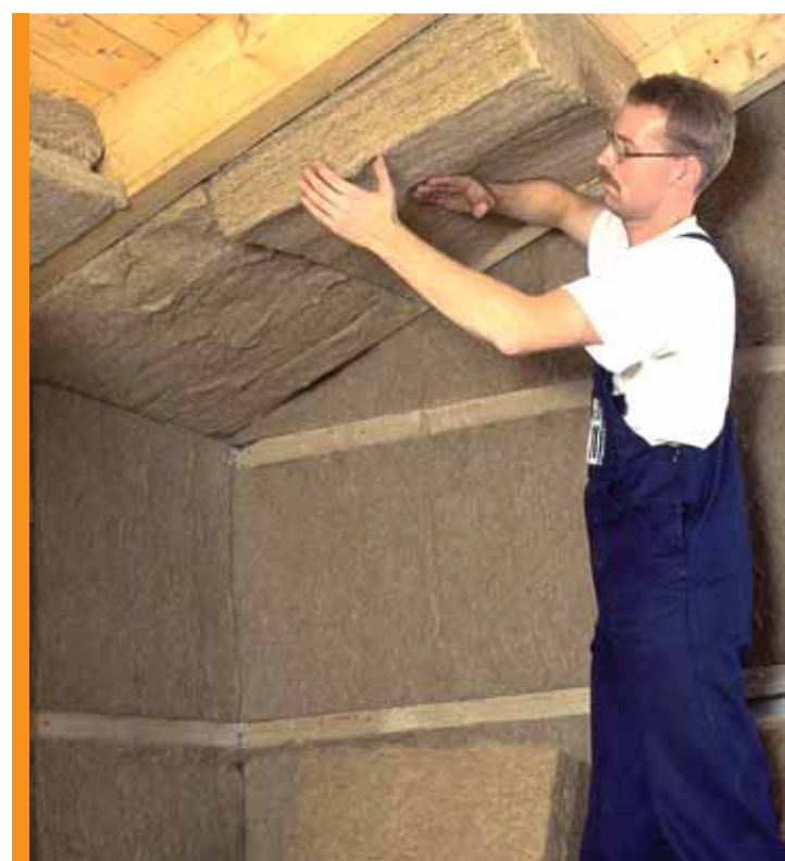
12 Dämmung mit Flachs (Flachshaus)
