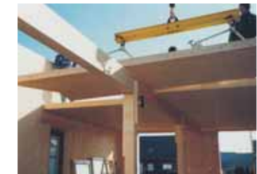
17 Eine Brettstapeldecke wird eingehängt (HolzHausplus)
