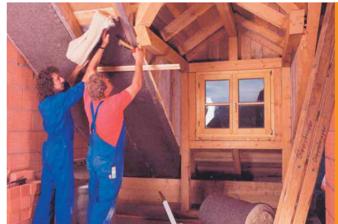
16 Zwischensparren- dämmung mit Schafwolle (Doppelmayer)
